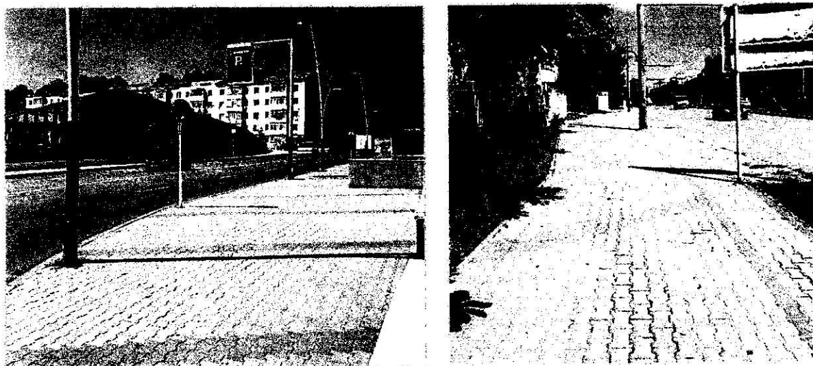
Figura 2.61. Trotuare în stare bună (Exemplificare).
