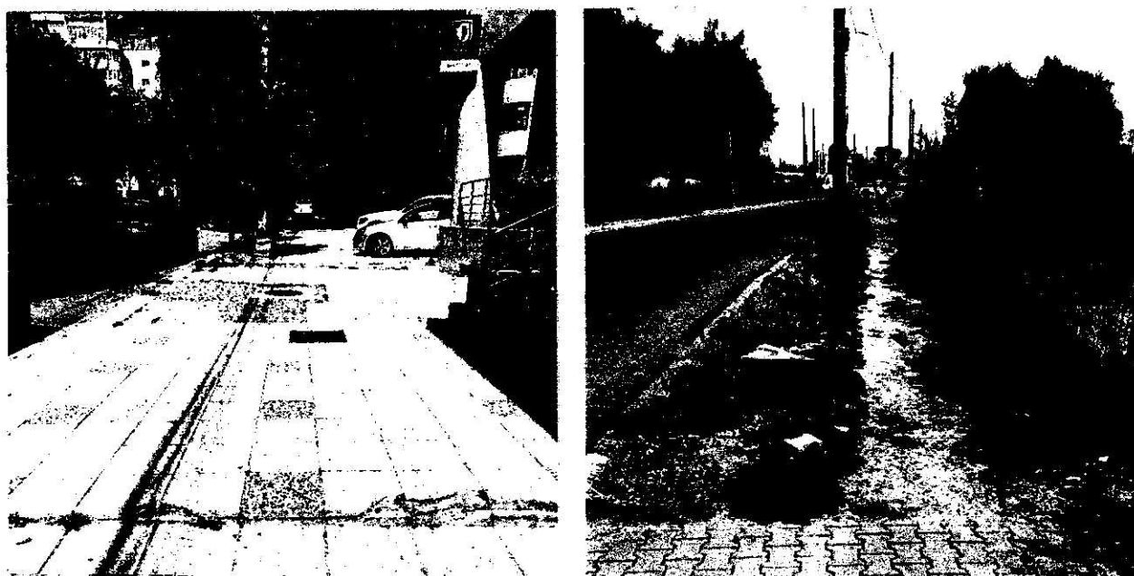
Figura 2.62. Trotuare în stare necorespunzătoare (Exemplificare).
