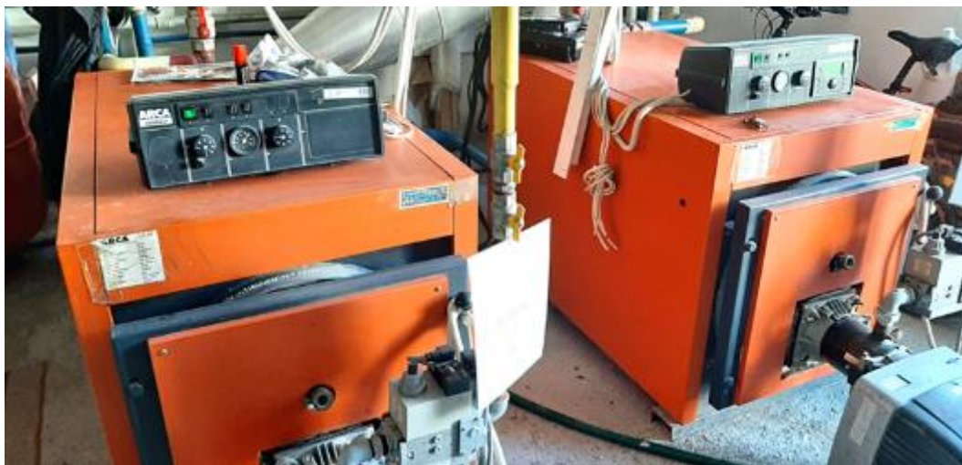
Fig. 5.55. Școala Gimnazială "Vasile Alecsandri" Vaslui - Centrala termică (2 cazane ARCA MK170)
