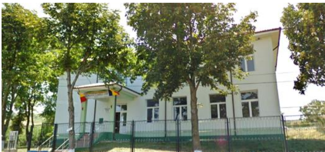
Fig. 5.58. Școala Gimnazială Brodoc, Vaslui - Corp Școală + Grădiniță
