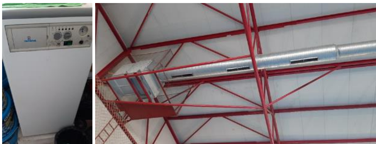
Fig. 5.29. Liceul cu Program Sportiv - CT + aeroterme cu GN la Sala de sport (str. Decebal)
