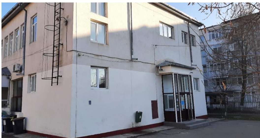
Fig. 5.41. Școala Gimnazială "Ștefan cel Mare" Vaslui - Corp B Ateliere
