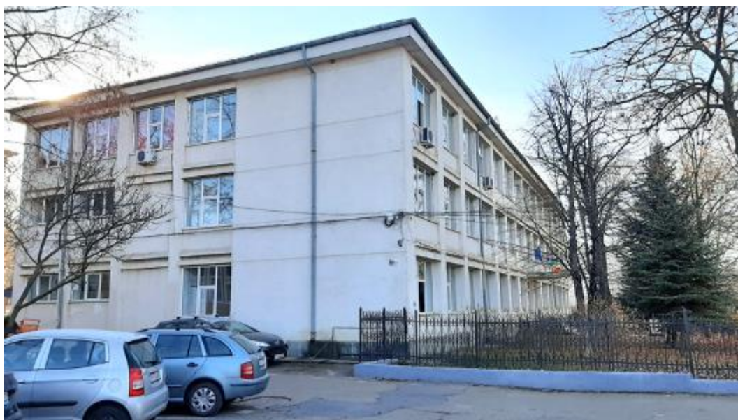
Fig. 5.15. Liceul Tehnologic “Ion Mincu” Vaslui - Corp A Școală
