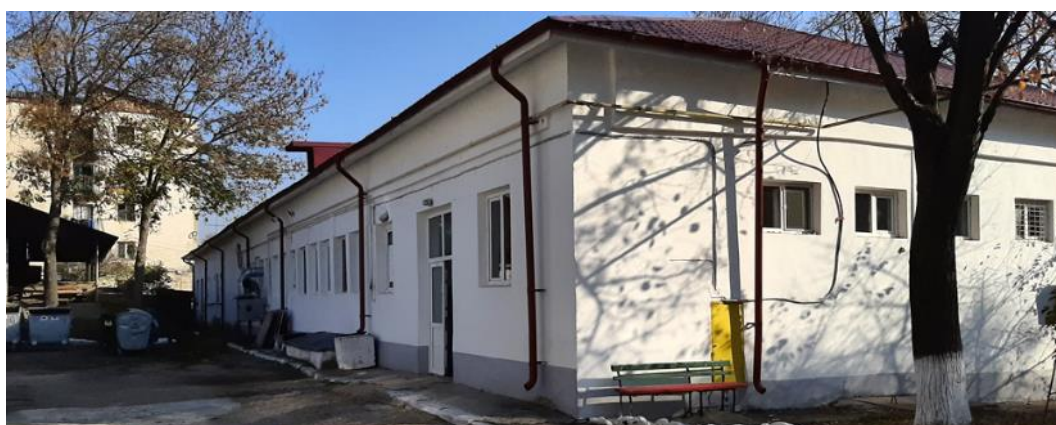
Fig. 5.12. Liceul "Ștefan Procopiu" Vaslui - Cantină
