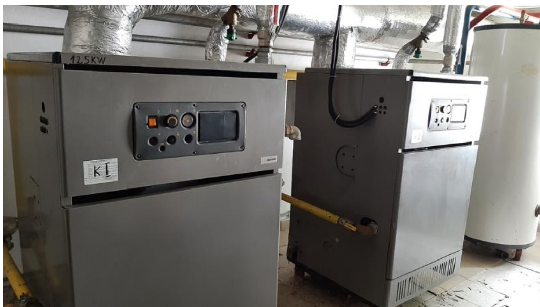
Fig. 5.19. Liceul Tehnologic “Ion Mincu” Vaslui - Centrala termică pentru Sala de sport (cazane cu tiraj natural)
