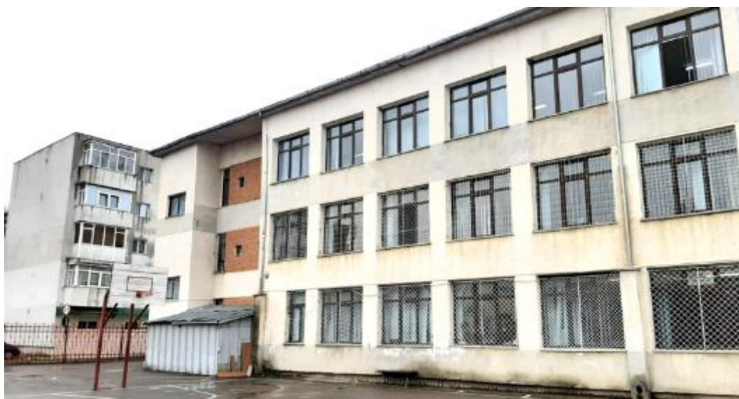
Fig. 5.50. Școala Gimnazială "Alexandra Nechita" Vaslui - Corp Școală
