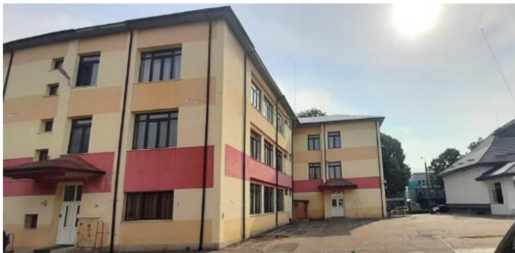
Fig. 5.32. Școala Gimnazială "Dimitrie Cantemir" Vaslui
