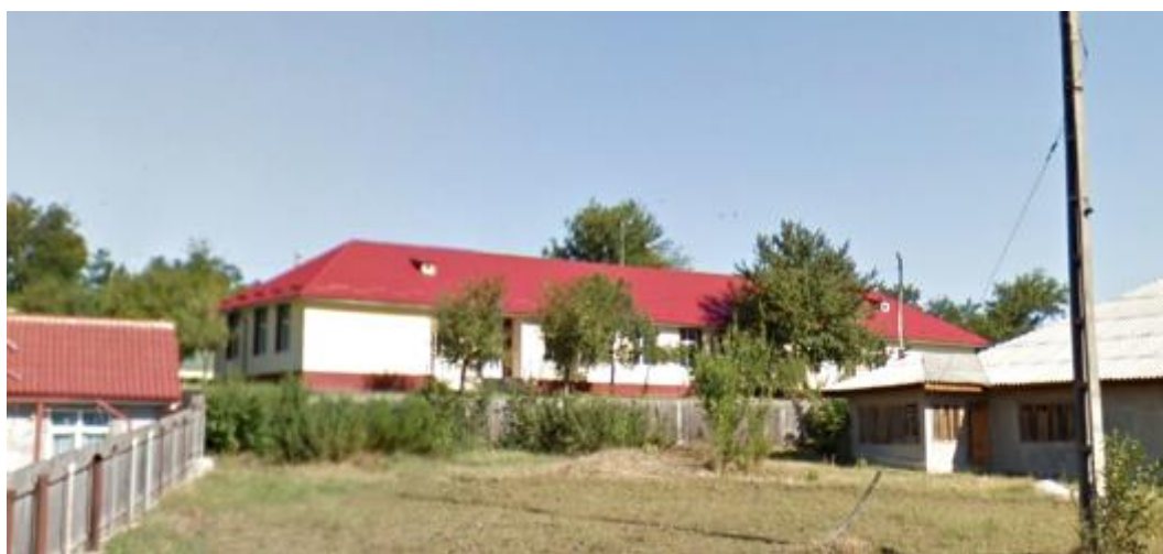
Fig. 5.59. Școala Viișoara, Vaslui - Corp Școală
