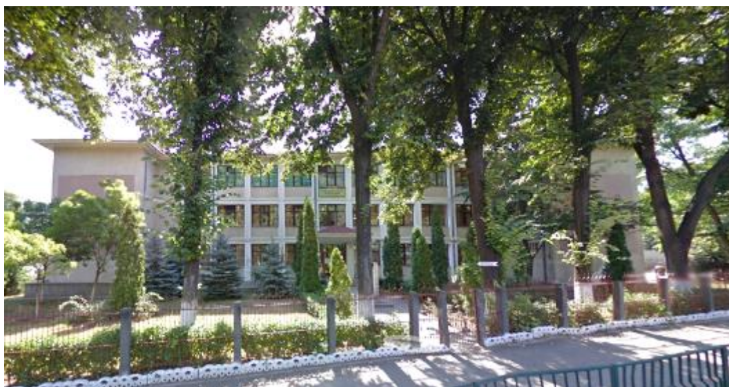
Fig. 5.40. Școala Gimnazială "Ștefan cel Mare" Vaslui - Corp A Școală
