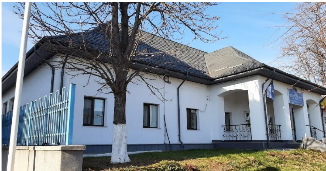
Fig. 5.26. Liceul cu Program Sportiv Vaslui - Corp Școală (str. Ștefan cel Mare nr.193)
