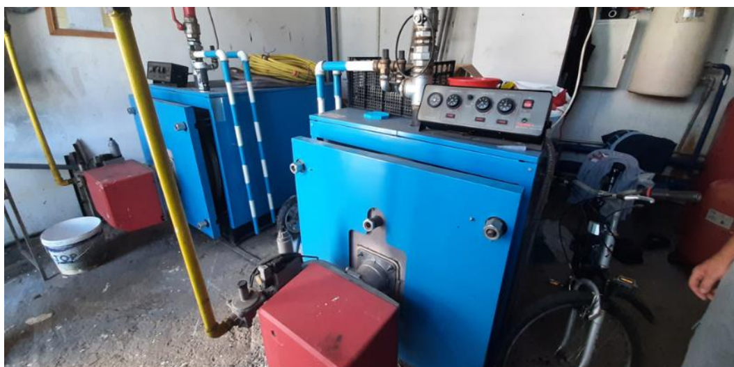
Fig. 5.28. Liceul cu Program Sportiv Vaslui - CT Corp Școală (str. Ștefan cel Mare nr.193)
